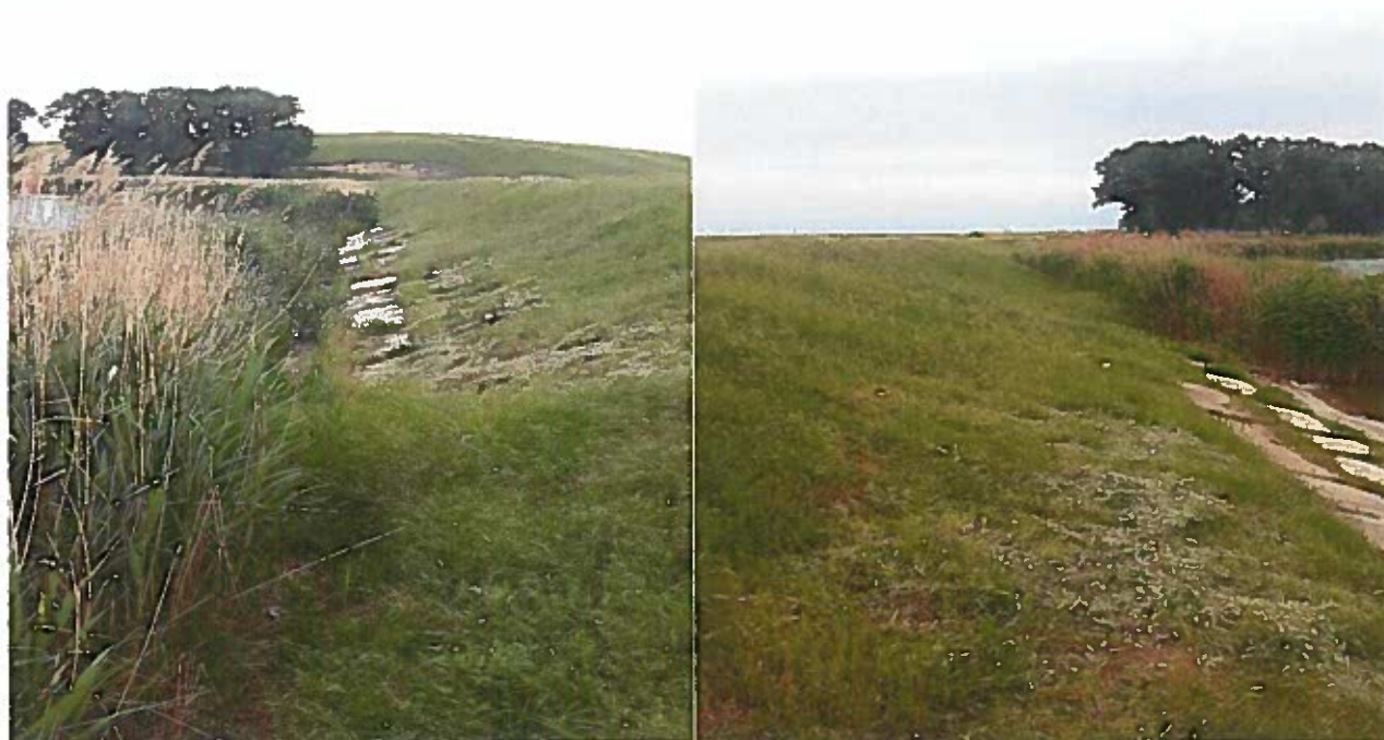
Figură 2 Pereu din dale din beton
