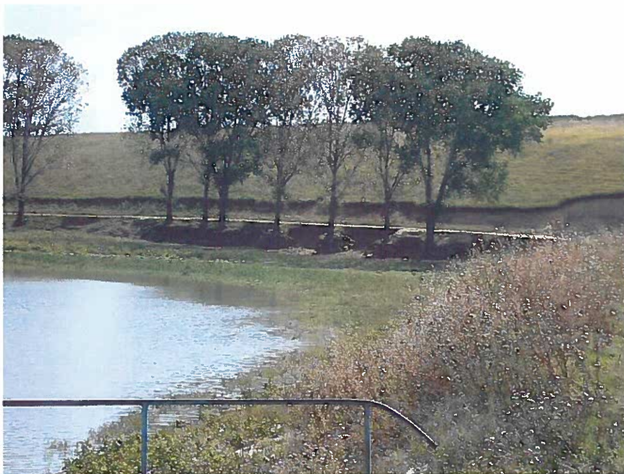
Figură 1 Acumularea Caraula - zona de incastrare a barajului mal stang
