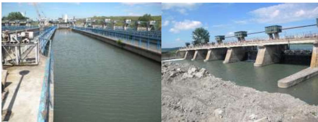
Barajul Ișalnița desnisipator (stânga) și zona mal stâng aval baraj (dreapta) 28
