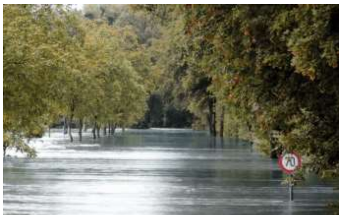
Drum acoperit complet de ape în timpul inundațiilor 54
