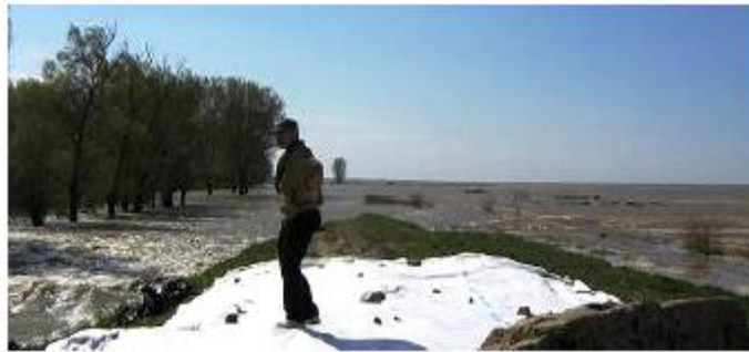
Foto 1 Pe digul de apărare împotriva inundațiilor-Fluviul Dunărea în timpul inundațiilor din 2006
