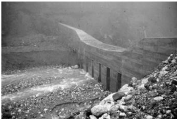
Figura 81. Baraj filtrant cu rol de stingere a proceselor erozive specifice unui torent
